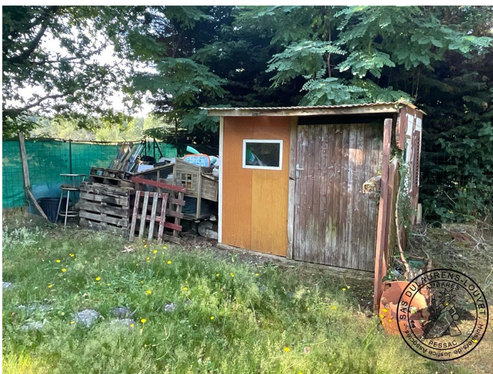
Cabanon de jardin, absence de dalle béton
