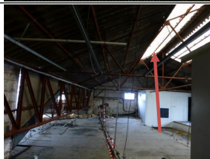
Photo n° Ph002 Localisation : Grenier réception marchandises Ouvrage : Toiture, terrasse et étanchéité - Plaques ondulées et planes Partie d'ouvrage : Plaques en fibres-ciment Description : Plaques en fibres-ciment
